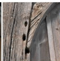
Schadhafter Kopfbandanschluss
